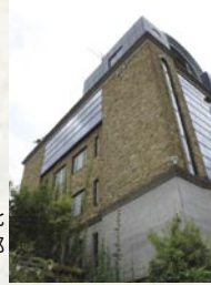
ビルの屋上・壁面緑化の“モデルハウス”東邦レオさまの本社ビル
